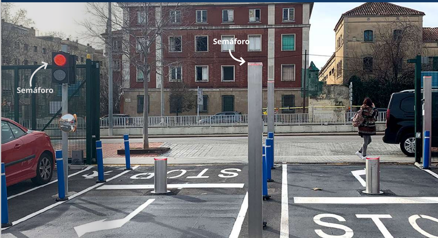
Instalación de una PILONA AUTOMÁTICA de 600mm de altura, con doble semáforo; en la salida sobre un poste y en el conjunto de totem con semáforo integrado, interfono y lector de tarjetas.
